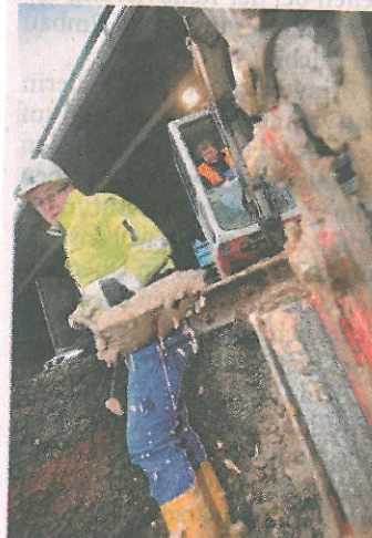
Zusammenarbeit: Haki San hebt mit dem Bagger grobe Erde aus. Sasha Bahndorf schaufelt.
